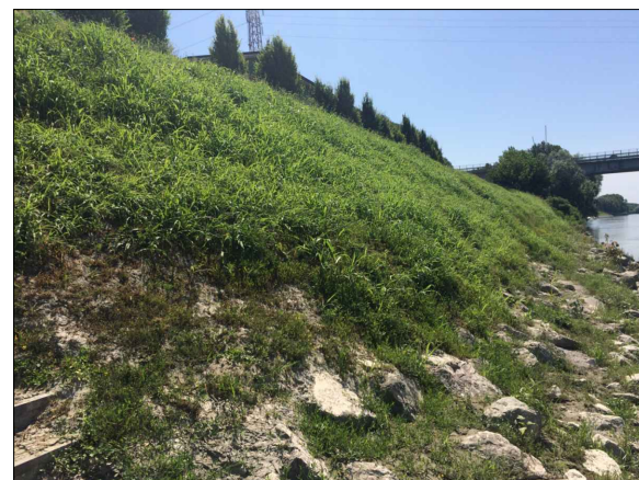
Particolare argine Po - lato Casalmaggiore (CR)
