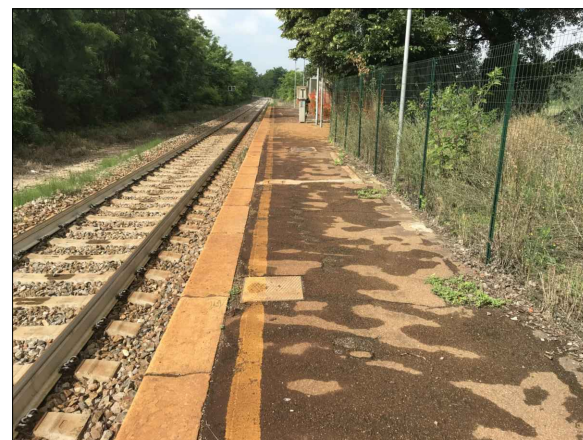
Piattaforma stazione Mezzano Rondani (PR)
