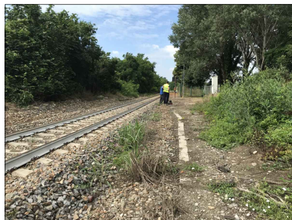
Stazione di Mezzano Rondani (PR)
