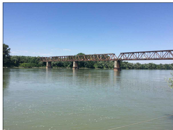
Vista del ponte ferroviario
