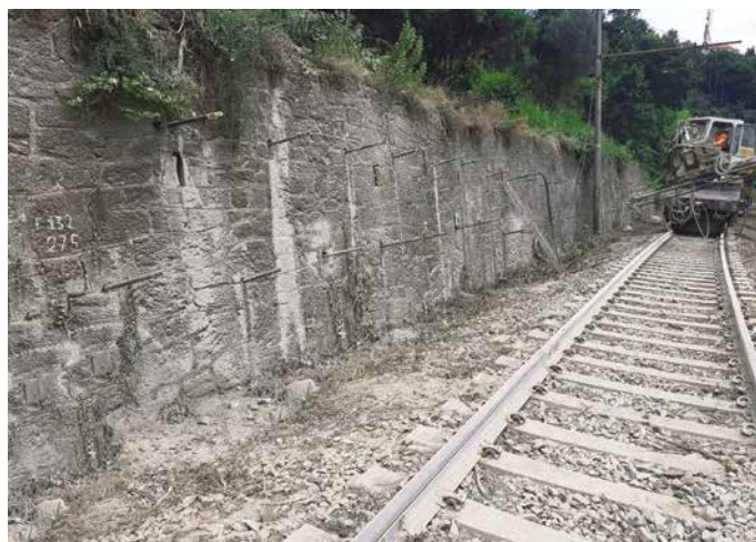
5. L'esecuzione del consolidamento sul muro esistente tramite chiodature con barre di ancoraggio autoperforanti
